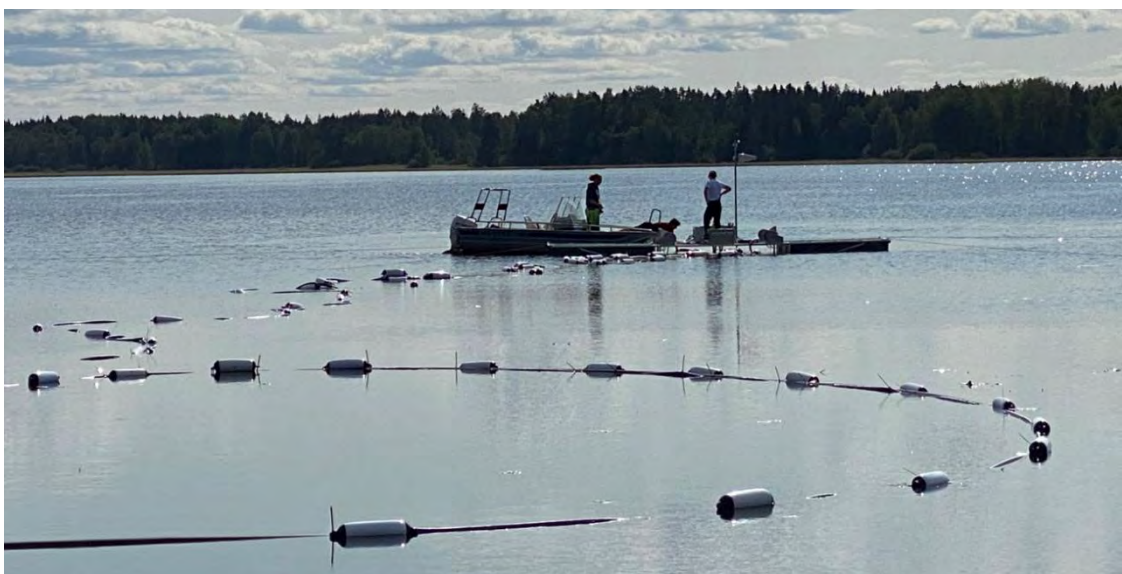
Figur 12. Utrustningen för lågflödesmuddring i drift. Flytetyg är fäst i slang och kabel så de syns väl. Vajrarna för manövrering kan anas löpa från flottens hörn. Foto: Bollnäs kommun.
