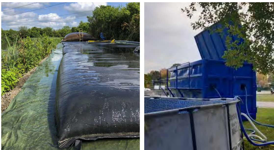
Figur 14. Avvattnig av sediment kan ske med olika tekniker, till exempel geotub (till vänster, foto Atek) eller lamellsedimenteringscontainer (till höger).
