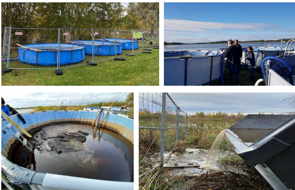
Figur 13. Löst flytande sediment pumpas in i en kedja av bassänger (övre raden, bilden till vänster foto: Bollnäs kommun). I främst den första bassängen samlas sedimentet på botten (nedre raden till vänster) och vattnet leds vidare för ytterligare rening. Det renade rejecktvaletnet går tillbaka till sjön. Bollnäs kommun har använt en välfungerande lösning med liftdumper där det renade vattnet tillåts överflöda (bilden nere till höger, foto: Bollnäs kommun).
